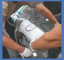
InnerSeal<sup>™</sup> Innerwrap<sup>™</sup> Lateral Connection Seal
